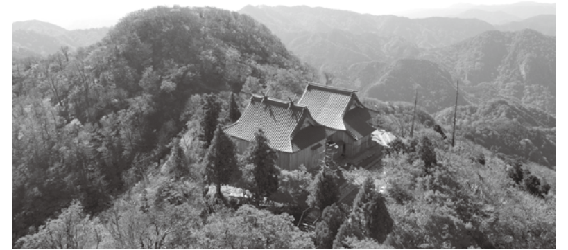
修復工事が完了し、参拝が可能となった英彦山神宮上宮
