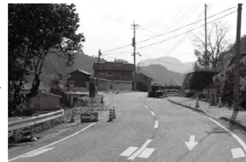
大量の土砂と流木に覆われた県道52号線と撤去が済んだ現在の状況
