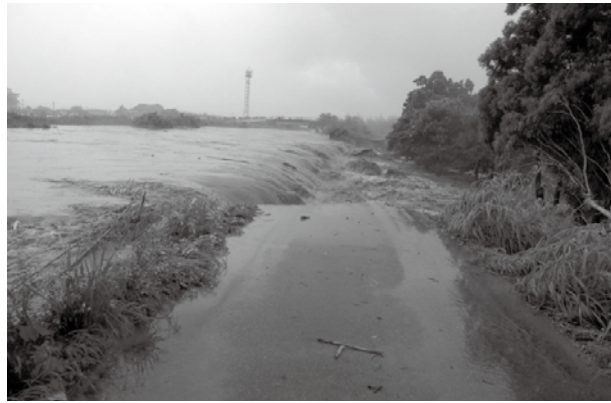
7月14日、午前9時頃、沖端川左岸中山の堤防が越水後、決壊
