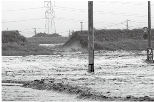
7月14日、午後1時20分頃、矢部川右岸六合の堤防が決壊
