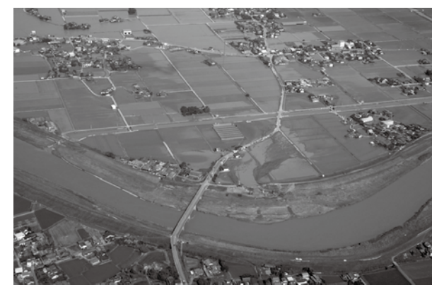
矢部川堤防が決壊した六合地区。津留橋(写真中央)そばの堤防が決壊し、浸水
