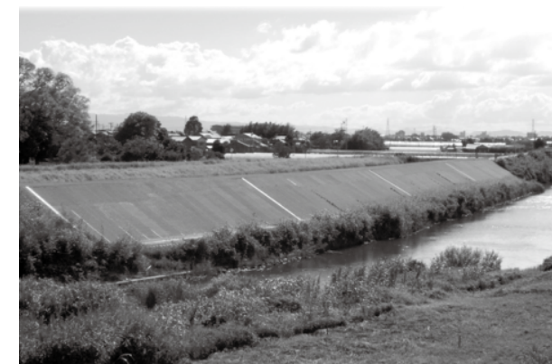
沖端川堤防の決壊箇所の復旧改修
