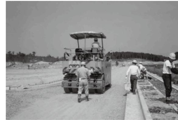
この後、プライムコートを散布し、アスコン舗装を施工する。
