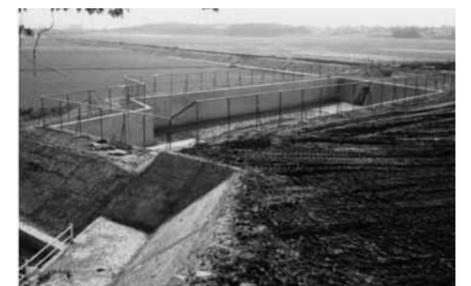
流出量の調整を目的とせず、土砂を沈殿させてわ水を放流するために設けられる。なお、貯留容量により調整池となる場合もある。(宮城県七ヶ浜町)
